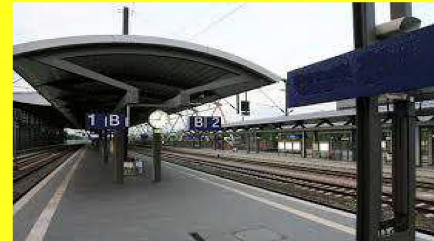
Andenes y bordes de andenes
