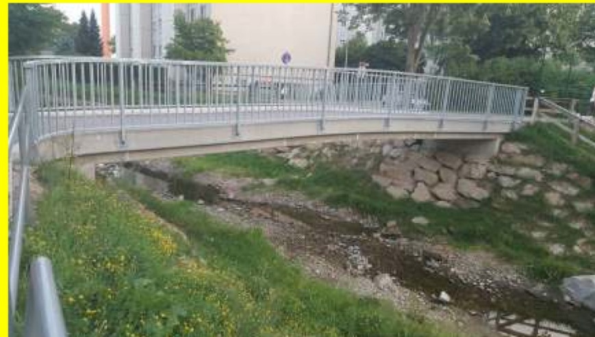
Protección contra torrentes y avalanchas
