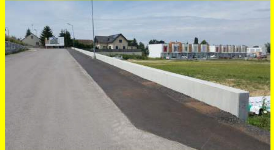
Muros de contención
