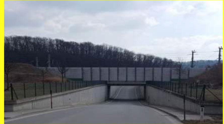
Pasos bajo puentes y laterales Zócalos y barreras acústicas
