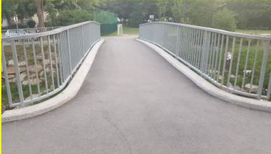
Protección contra torrentes y avalanchas
