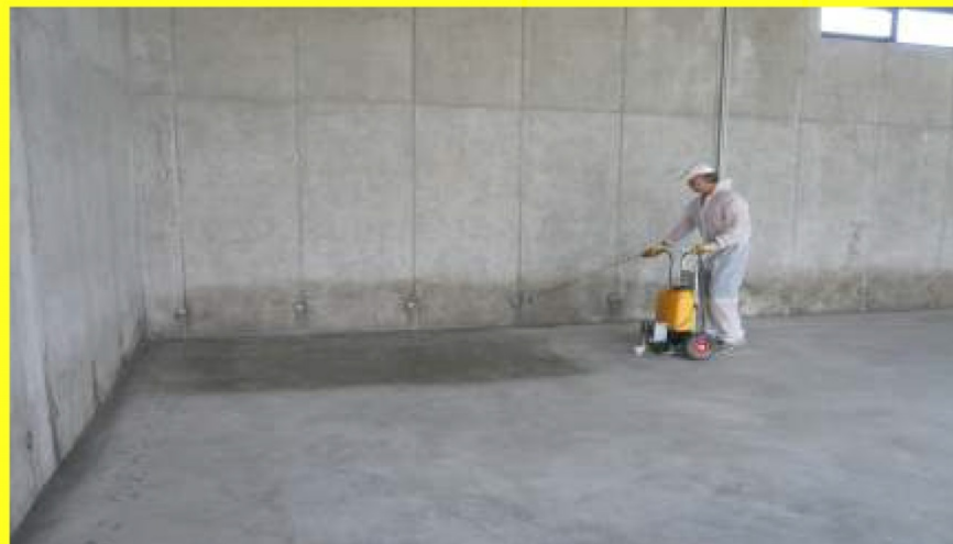
Centros operativos y obras de construcción
