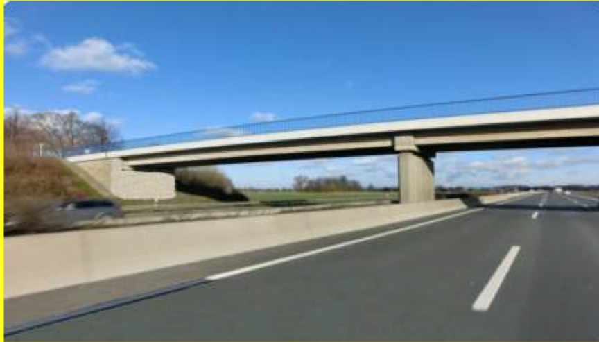
Puentes, pilares y vigas de borde Medianas
