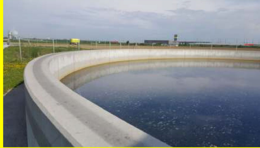
Depuradora y borde de estanque
